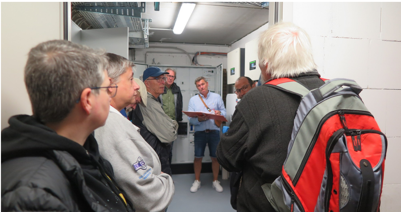
Gedränge im Elektroraum
